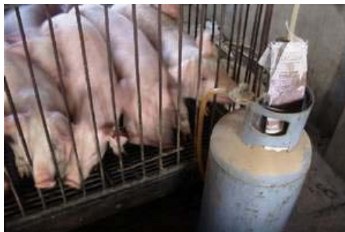
圖 9.10 水電瓦斯等管線應遠離豬隻避免遭咬破造成危險
