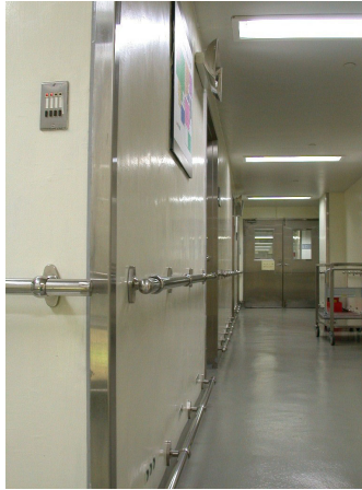
圖 4.10 走廊的牆壁及牆角需具有防撞桿
