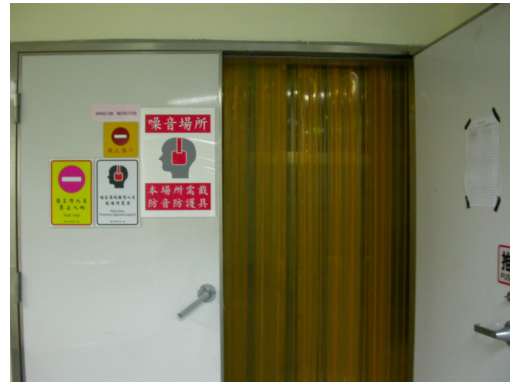
圖 4.68 機房門口加裝厚重隔簾，防止機房內蚊蟲於開門時飛出
