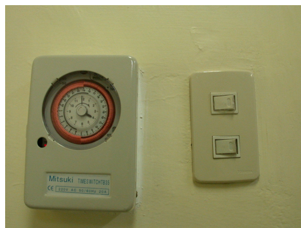
圖 4.8 自動計時器控制房舍內的光照時間
