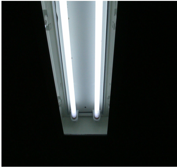
圖 4.7 內藏式的照明設備
