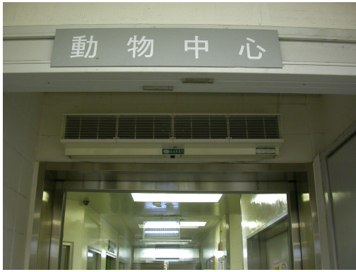
圖 4.67 動物中心入口處裝設風簾，阻止蚊蟲隨人員進入設施內
