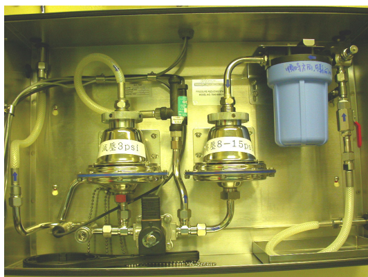
圖 4.36 自動給水系統-降低壓力
