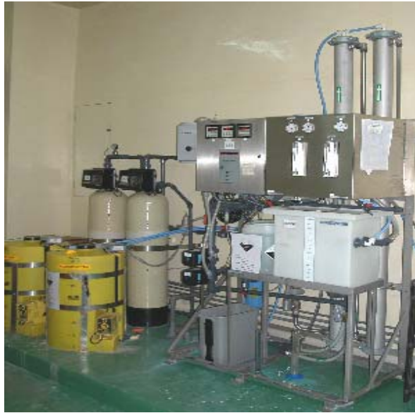
圖 3.5 逆滲透膜 (RO) 純水製造系統
